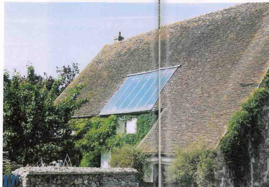
◀ La verrière aux profilés fins s'inscrit sans saillie et dans la géométrie du pan du toit, éclairant largement l'intérieur de la maison.
