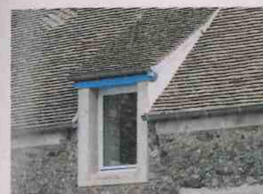
◀ Lucarne rampante engagée, un modèle très simple.
