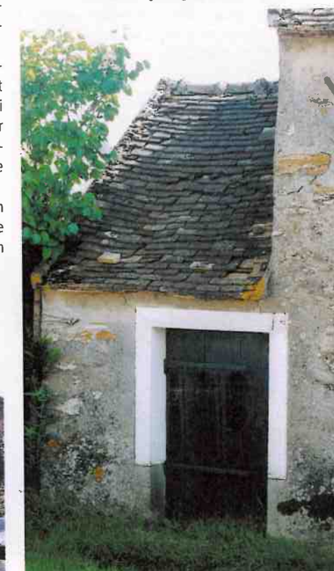
L'annexe vient épauler le bâtiment principal. ▼
