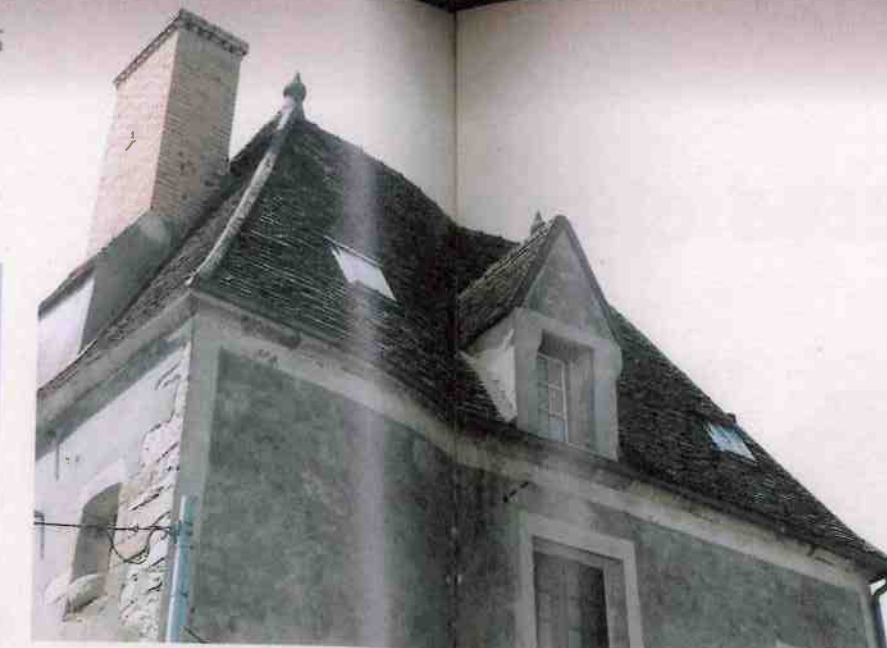
◀ Lucarne pignon maçonnée datant du XVII e siècle. Elle est assez massive, mais bien proportionnée par rapport au grand toit fortement pentu.
