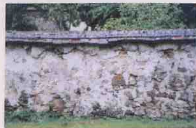
▲ Mur plein en maçonnerie de meulière.
