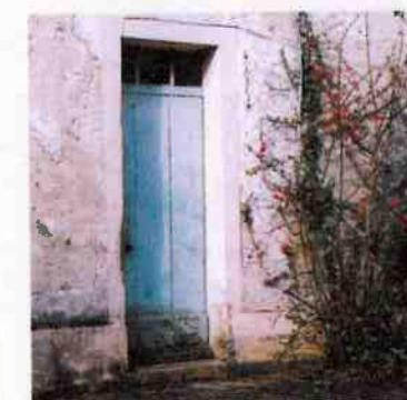
Une bande-plate* lisse en enduit souligne discrètement l'ouverture de la fenêtre. ▼
