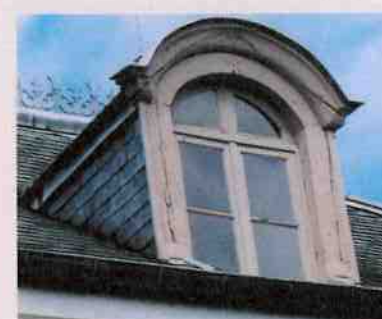
◀ Lucarne demi-ronde charpentée.
