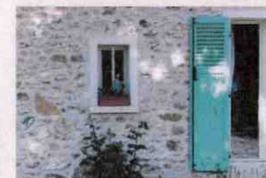
Enduit à pierre vue. ▲
