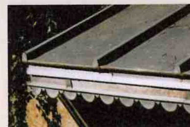
◀ Auvent en zinc d'un lavoir privé.
