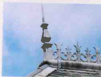
▲ Epi de faîtage et crête en zinc.
