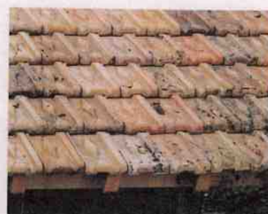
Tuile à emboîtement losangée fabriquée localement. ▶
