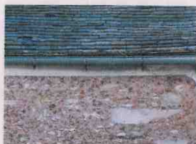
Enduit coloré à la brique pilée. ▼
