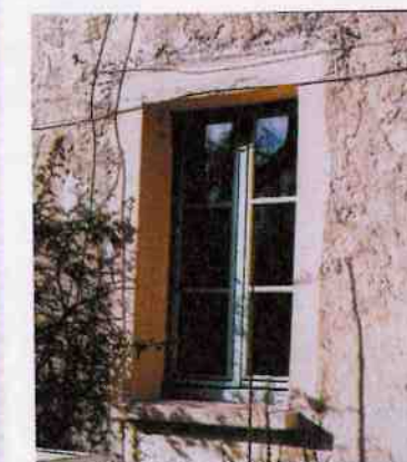
Une bande-plate* lisse en enduit souligne discrètement l'ouverture de la fenêtre. ▼
