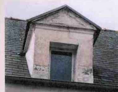
◀ Lucarne à fronton maçonnée.
