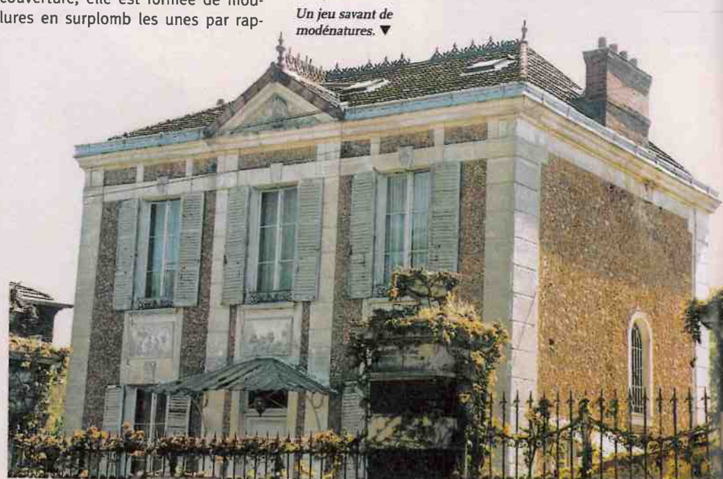
▲ La corniche est essentielle pour la protection et l'aspect de la façade.
