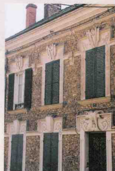
Exemple atypique d'ornementation des linteaux. ▶
