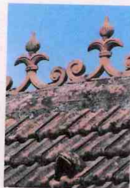
▲ Crête et châtière en terre cuite.
