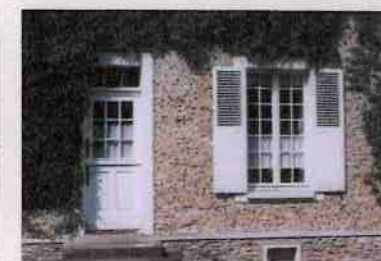
▲ Des morceaux noirs de mâchefer* sont intégrés au rocaillage.
