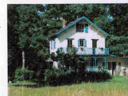
► Villa en bois construite dans l'esprit des villas de bord de mer.
