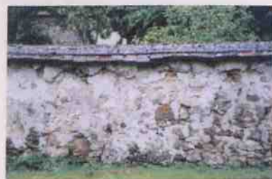
▲ Mur plein en maçonnerie de meulière.
