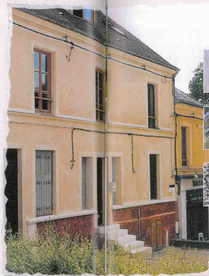
▲ L'enduit couvrant doit être conservé en évitant de mettre à nu la pierre.
