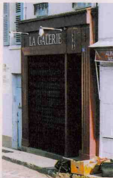
Dispositif fréquent d'éclairage d'une enseigne. ▼
