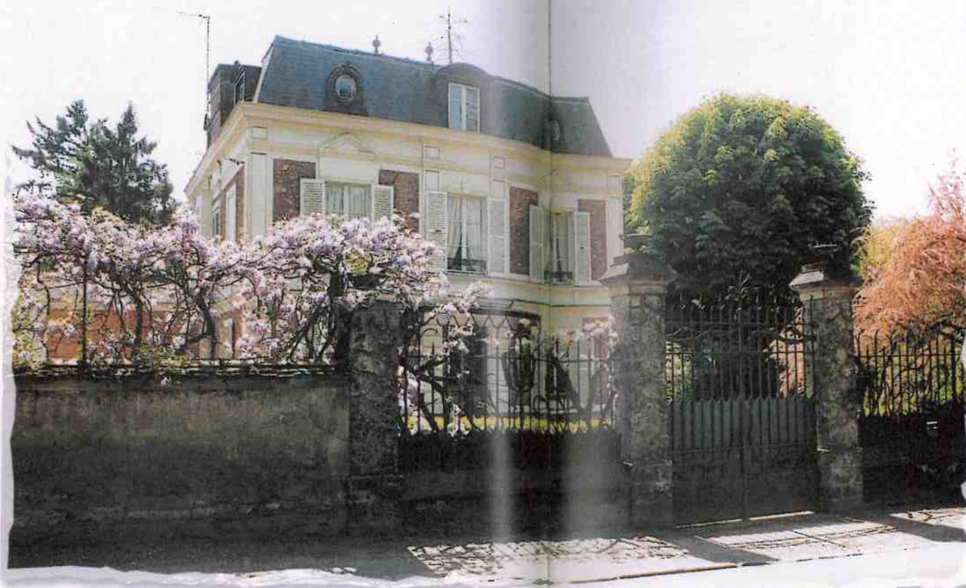
▲ De nombreuses maisons bourgeoises ont été édifiées le long des rues "de la Porte de Paris" à Chevreuse et "de Paris" à Saint-Rémy-lès-Chevreuse (R.D. 906)
