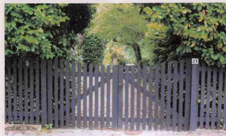
◀ Clôture basse en bois au dessin très simple. Les peintures microporeuses d'excellente durabilité permettent le choix de la teinte.
