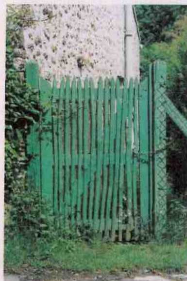
▲ Portillon en échelas de châtaignier peint. Les lames de bois espacées assurent une certaine transparence. Portes et portails peuvent aussi être en planches jointives ou en panneaux de bois qui masquent les vues.
