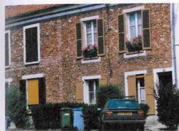
▲ Le rocaillage* est souvent réalisé avec un enduit à base de brique pilée qui donne cette teinte rosée.
