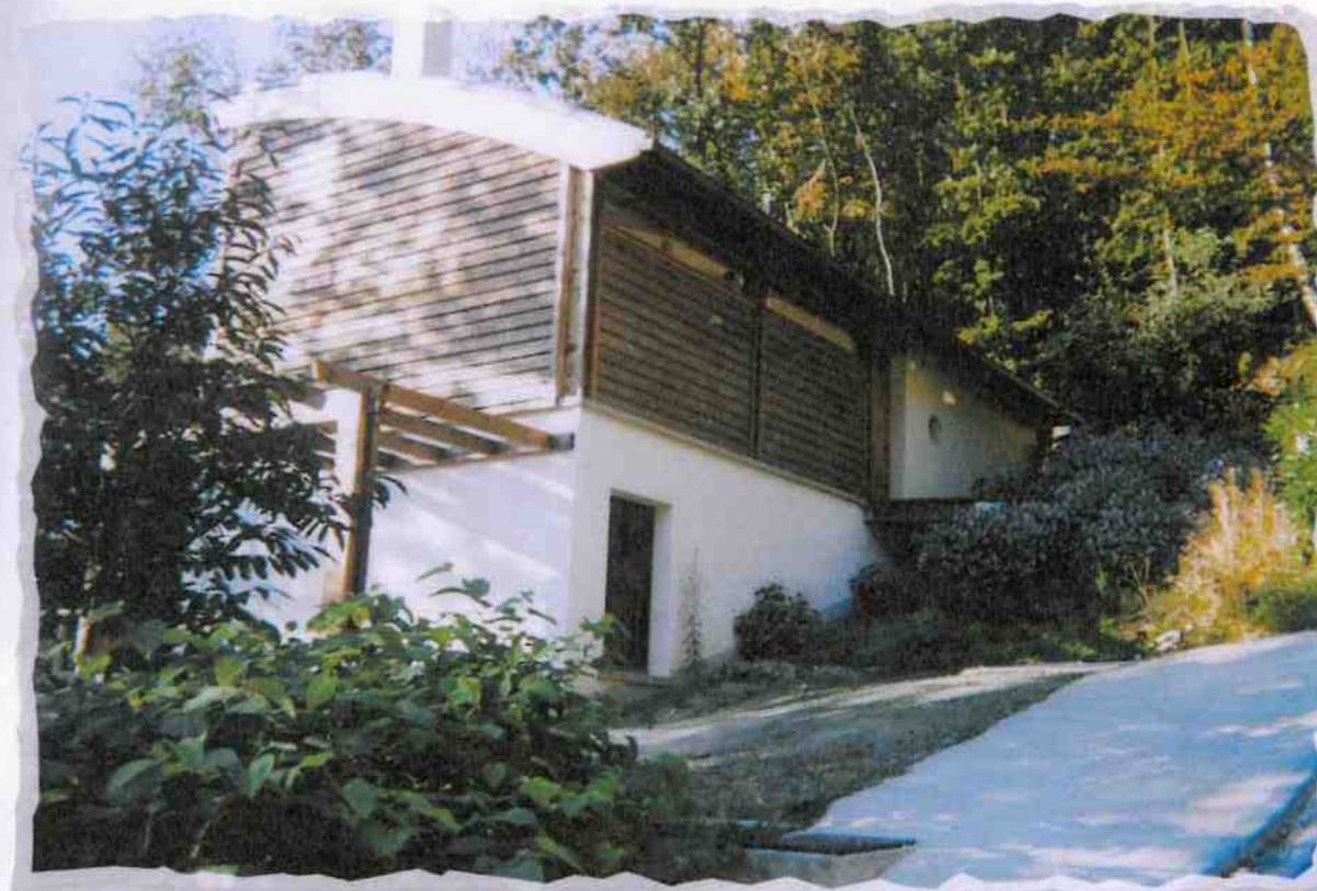
◀ Semi-enterrée, la maison respecte la pente naturelle du terrain. Architecte : Christine Novak.
